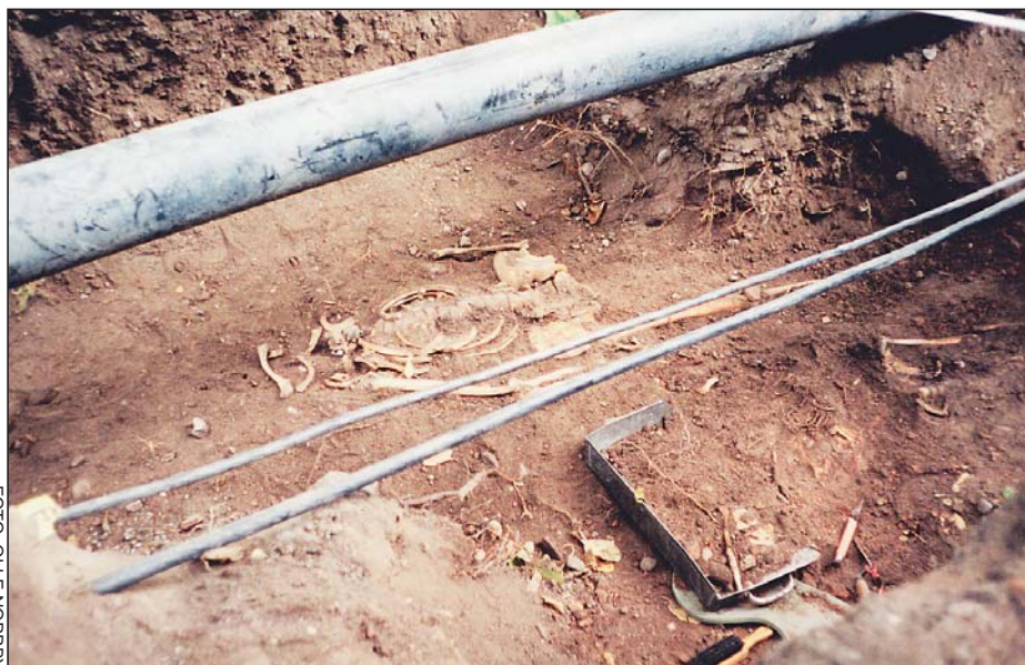
På grund av att skeletten blev för många (totalt 80 stycken) togs beslut att lyfta sprinklerservicen till Klara kyrka över frostfritt djup och förse den med elvärme.
