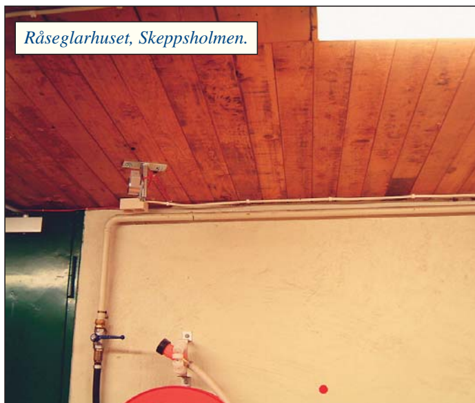
Anslutningspunkt för boendesprinkler som tekniskt byte mot alternativ utrymningsväg ( t v). Ventilkoppl för boendesprinkler ( t h).
